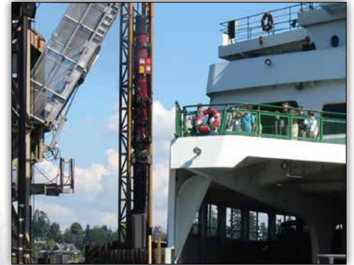
D46 HINCA PILOTES DE DELFÍN EN LA TERMINAL DE TRANSBORDADOR DE BAINBRIDGE ISLAND.
