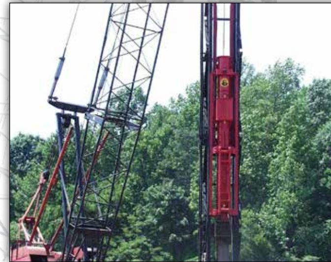
UN D19-42 HINCA UNA VIGA EN H EN NORTH CAROLINA.
