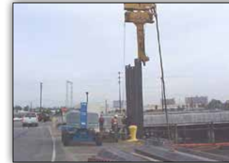
EXTENSIÓN HÍBRIDA DENOMINADA AGUJÓN DE CALIFORNIA PARA DIMENSIONES DE TRABAJO ESTRECHAS.
