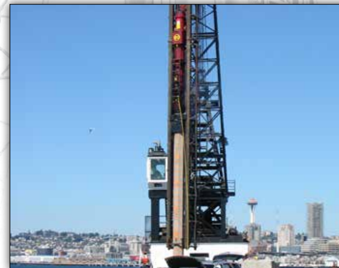
UN D62 HINCA PILOTES DE PRUEBA EN LA TERMINAL 18 EN SEATTLE, WA.
