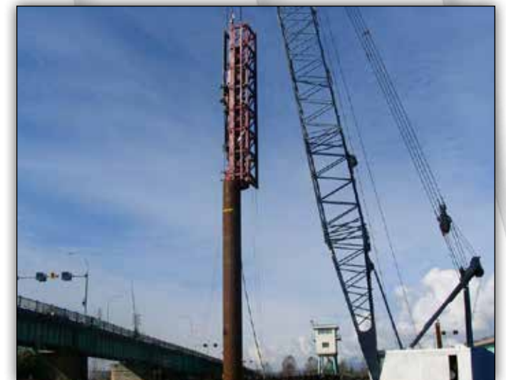
EL D180-42, EL MARTILLO DIESEL APE MÁS GRANDE EN NORTEAMÉRICA HINCA UN PILOTE DE TUBO DE 42" EN COQUITLAM, BC.
