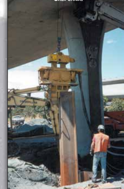
APE 150 EQUIPADO CON UN SUPRESOR DE BAJA CAPACIDAD PARA TRABAJO DE ACTUALIZACIÓN EN CALIFORNIA.
