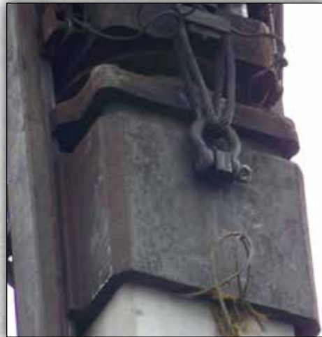
CASCO DE CAJA DE DOS PIEZAS PATENTADO.
