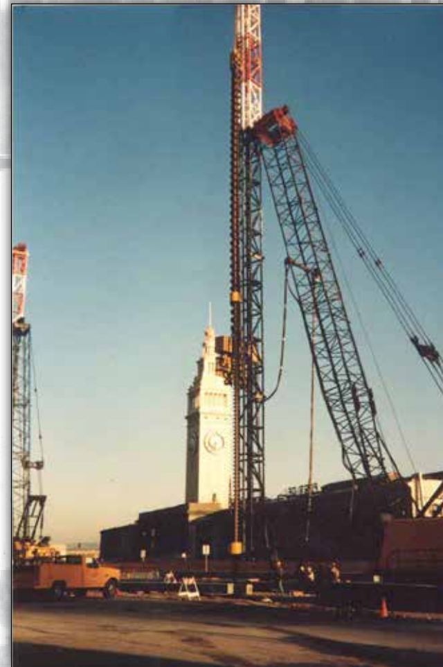
UNA PERFORADORA APE 75 EN UN FORMATO DE PERFORACIÓN PREVIA AL LADO DE UNA GUÍA FIJA CON UN KING KONG EN SAN FRANCISCO, CA PROPIEDAD DE KIEWIT.
