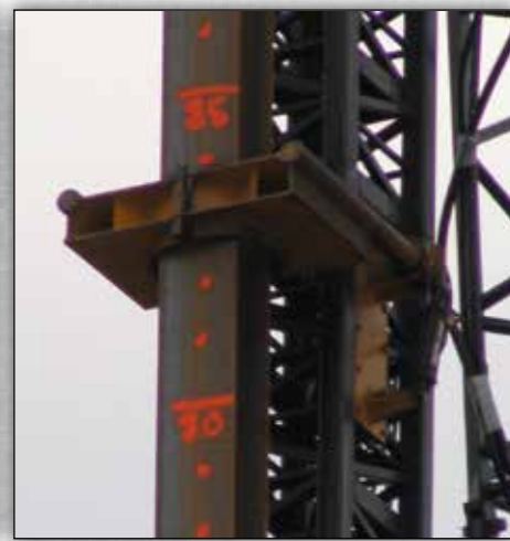
COMPUERTA DE PILOTE FLOTANTE EN LA GUÍA DE SUSPENSIÓN DELANTERA.
