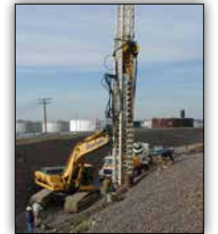
MONTADO EN LA EXCAVADORA
