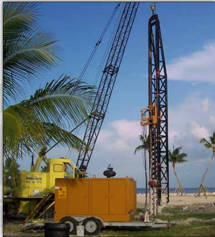
UNA PERFORADORA MODELO 20 EN UNA GUÍA OSCILANTE.
