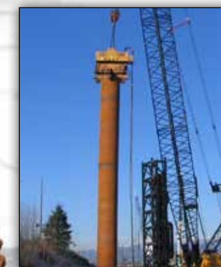
VIBRO MODELO 600 CON PILOTES DE 1.8 M DE ACABADO D180-42.
