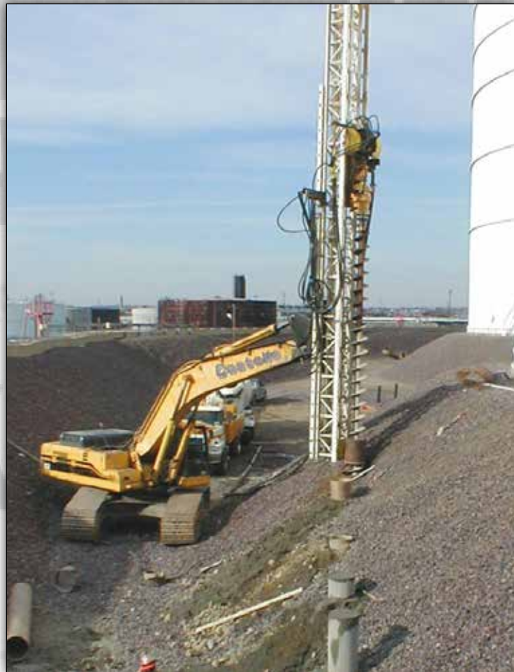
PERFORADORA MODELO 20 MONTADA EN LA GUÍA DE CREMALLERA Y PIÑÓN APE CON 15,000 LIBRAS DE CAPACIDAD DE EMPUJE.
